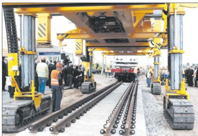
Укладка железнодорожного полотна скоростной магистрали «Рэйл Балтика»
