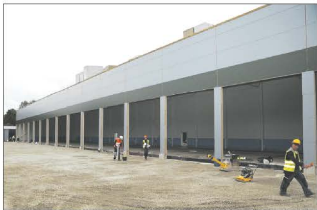
Возведение боксов для военной техники на военном полигоне Тапа (Эстония)
